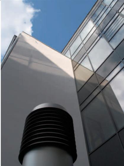
Der große »Zylinder« saugt Frischluft an und lässt diese in das Gebäude.
