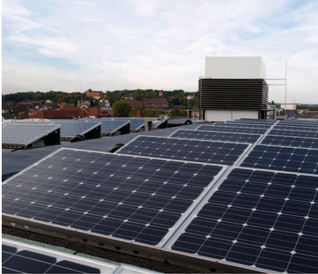
Auf dem Dach befinden sich eine 88 m<sup>2</sup> große **Fotovoltaikanlage** für die hauseigene Stromproduktion. Die 52 Module haben eine Leistung von 11,5 kWp.
