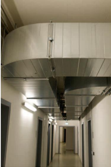
Die **Be- und Entlüftungsanlage** sorgt dafür, dass frische Luft herein und verbrauchte Luft nach draußen strömen kann.
